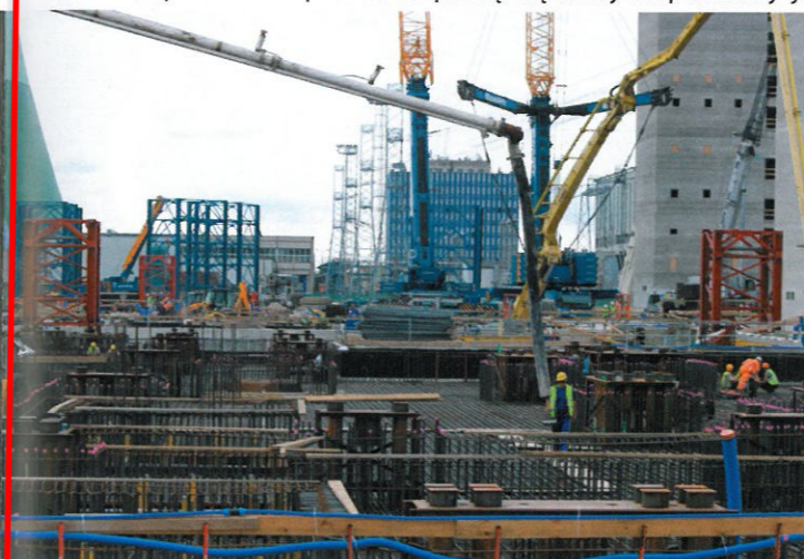
Budowane w Opolu bloki dostarczać będą 1800 MW. Fot: UMWO
